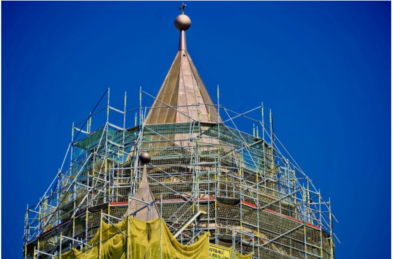
Kirche im Umbau
